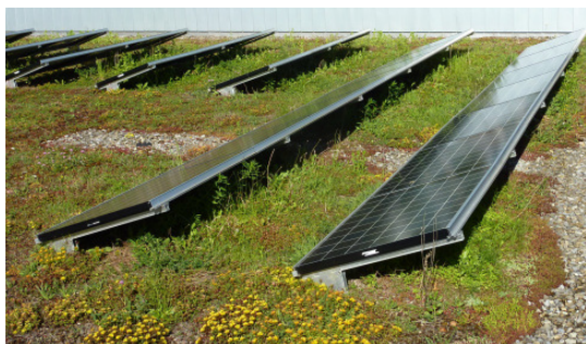
Bild 3: Dieses Befestigungssystem für Solarmodule ist für Gründächer geeignet. Die gesamte Gründachfläche ist gut zugänglich.
