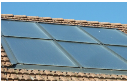
Bild 1: Selbstreinigungseffekt funktioniert bei geeignetem Neigungswinkel
